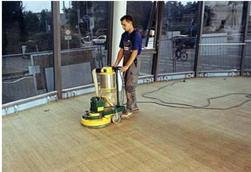
Abb.3.2-16: Hohe Schadstoffkonzentrationen während Schleifarbeiten in Gebäuden (Quelle: ÖBZ – Schulungsfolien, Foto: Fa. Lägler)
